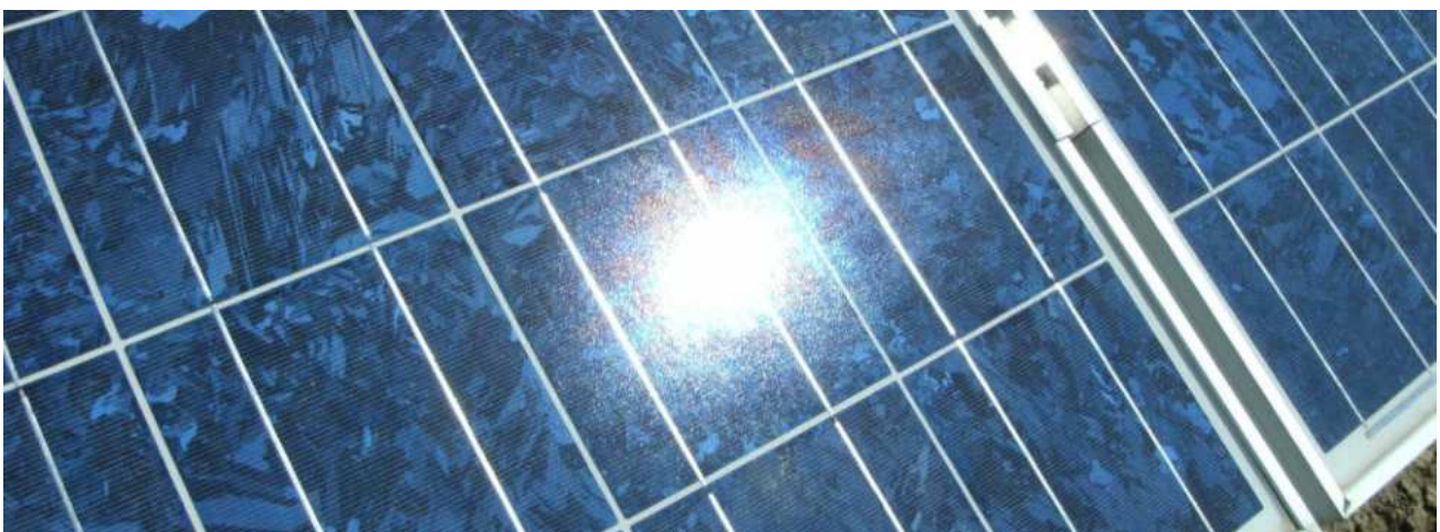
Bild 3.2.2: Diffuse Reflexion von direkten Sonnenlicht (Einstrahlung ca. 980 W/m 2 ) auf einem PV Modul (Quelle: SolPEG)
