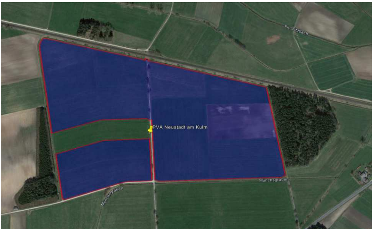
Bild 2.1.3: Details der PV Anlage (Quelle: Google Earth / SolPEG)
